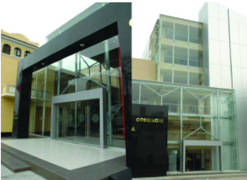
Detalle de arco de ingreso (izq.). Vista general de ampliación (der.)
